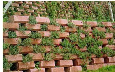
Figura 44 - Barriera antirumore in calcestruzzo ed elementi vegetali
