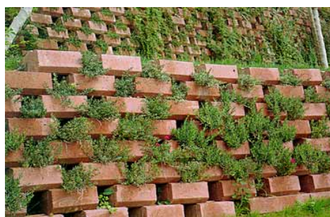
Barriera antirumore in calcestruzzo ed elementi vegetali
